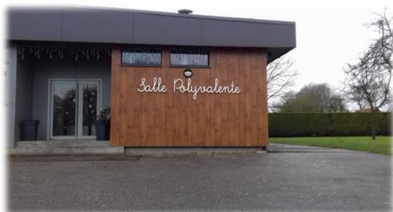
Mise en place d'un lettrage sur la salle polyvalente
